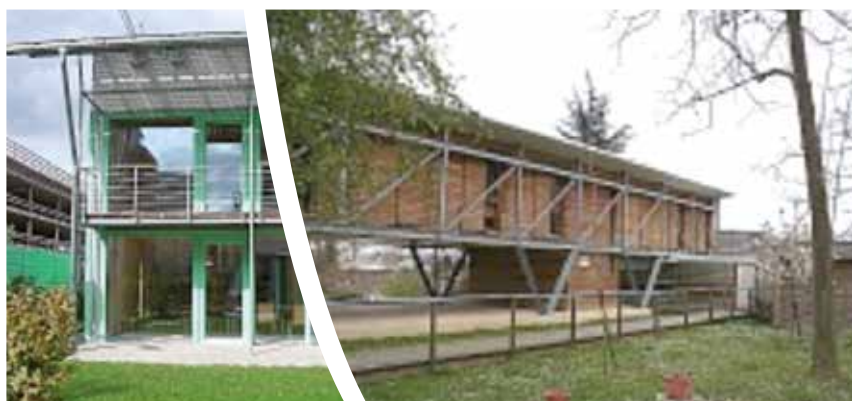
Construction sur poteaux béton
