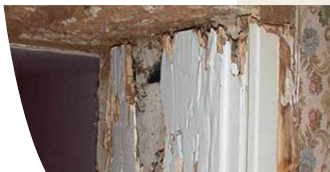
Attaques sur un montant de porte
