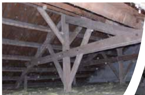
Charpente en combles perdus
